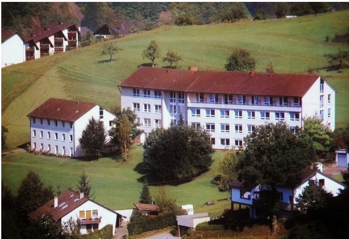
Das 1965 eingeweihte Schiltacher Krankenhaus auf dem Hoffeld
